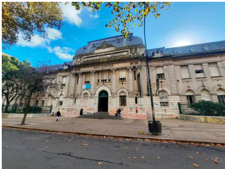
Imagen 2. Título: Frente del edificio del ISFD N° 95. Fuente: Ana Carou
