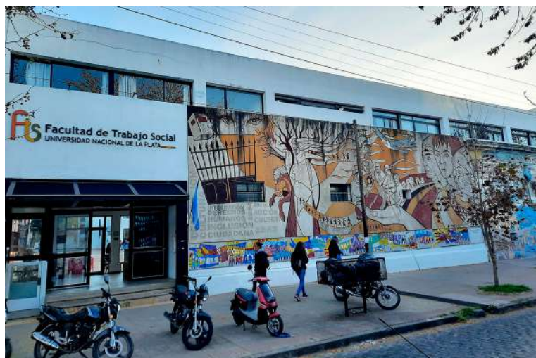
Imagen 1. Título: Frente del edificio de la Facultad de Trabajo Social - UNLP.
