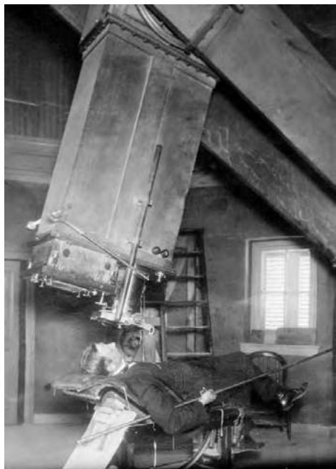
Figura 12. El Astrográfico instalado en la cúpula de la vieja sede del Observatorio Nacional Argentino, fotografía tomada el 12 de noviembre de 1912. En posición de observación se encuentra el fotógrafo Roberto Winter, uno de los tres primeros contratados para el trabajo del Catálogo Astrográfico y la Carta del Cielo, quien obtuvo la mayor parte de las placas fotográficas (Archivo OAC).
