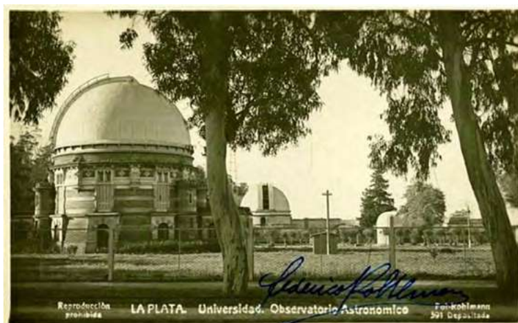
Figura 14. Edificio Gran Ecuatorial (frente). Al fondo se observa el pabellón del reflector de 80 cm [Fig. 16]. Foto firmada por Federico Kohlmann, extraída de la Biblioteca Nacional de la República Argentina.
