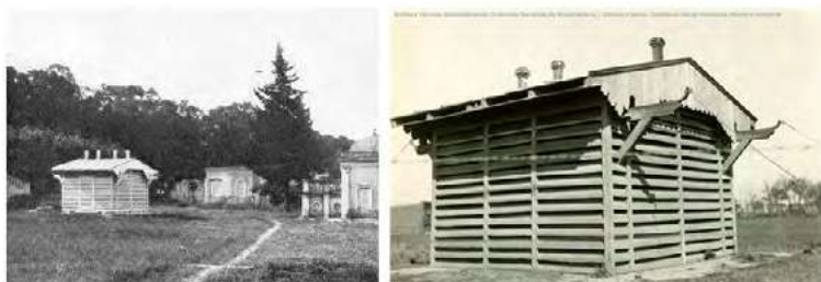
Figura 19. Izquierda: Ubicación del refugio (a la izquierda), al fondo se destaca el pabellón del círculo meridiano y a la derecha se ve parte del pabellón de sismógrafos. Foto extraída de Hussey et al. (1914). Derecha: Refugio del Telescopio Wanschaff (Archivo Técnico Administrativo Nacional de Arquitectura/Distrito Centro. Gentileza Oscar Herminio Herrera Gregorat).
