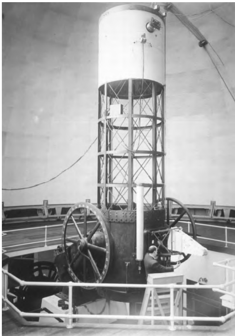
Figura 16. Telescopio de 1,54 m de la Estación Astrofísica de Bosque Alegre, en el foco newtoniano se encuentra instalada la cámara fotográfica para imágenes directas, mientras que en el foco Cassegrain se puede ver el espectrógrafo estelar fotográfico, lo ajusta el destacado ayudante fotógrafo David McLeish (Archivo OAC).
