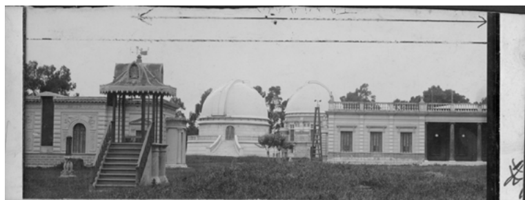
Figura 11. Vista del conjunto de edificios. De derecha a izquierda, edificio principal, Gran Ecuatorial, edificio del Reflector, edificio Meridiano y casilla de observación meteorológica.
