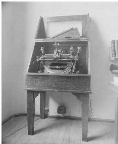
Figura 13. Una de las cinco máquinas de medir placas fotográficas que se emplearon en el Observatorio Nacional Argentino para el Catálogo Astrográfico. Adquirida por el Dr. M. Thome a Repsold, comenzó a usarse en 1910 (Archivo OAC).
