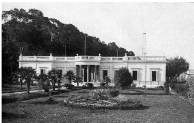
Figura 12. Vista del edificio principal, vista norte (arriba) y vista sur (abajo). Archivo del Museo de la Facultad de Ciencias Astronómicas y Geofísicas.
