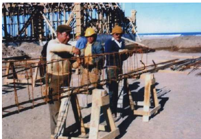
Figura Nº 11. Armado de armadura de hierro del Complejo Balneario Punta Mogotes. Fuente: Gentileza del Sr. Pablo Roda.
