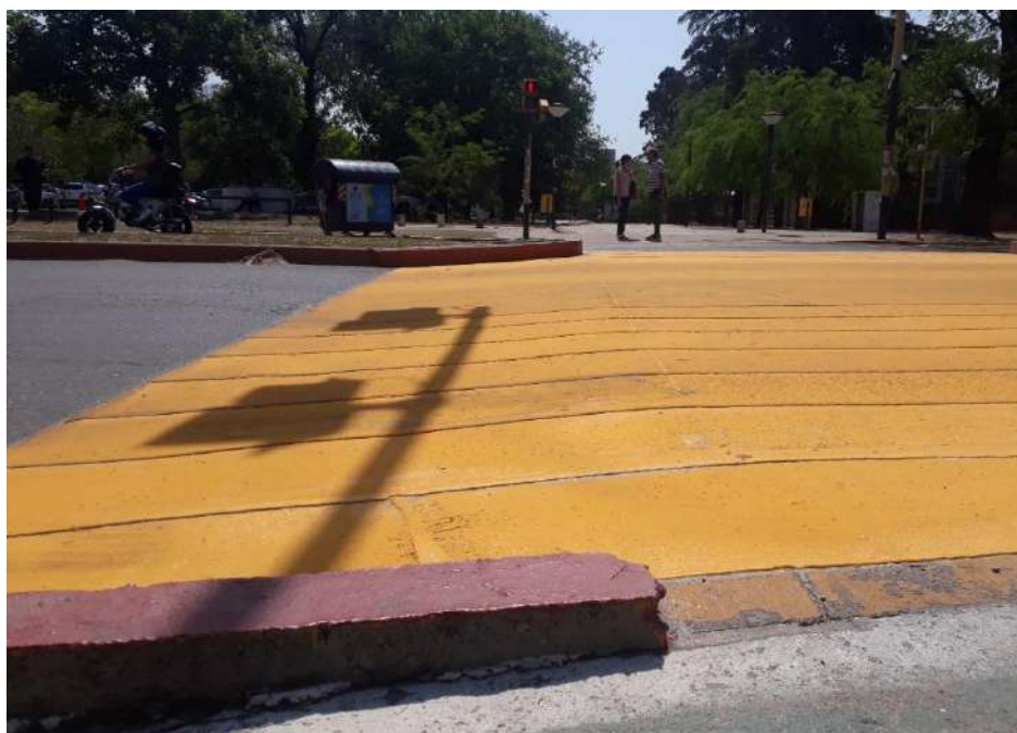
Figura 1: Cruce peatonal avenida Valparaíso.
