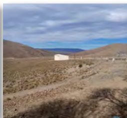
Planta de residuos cloacales
